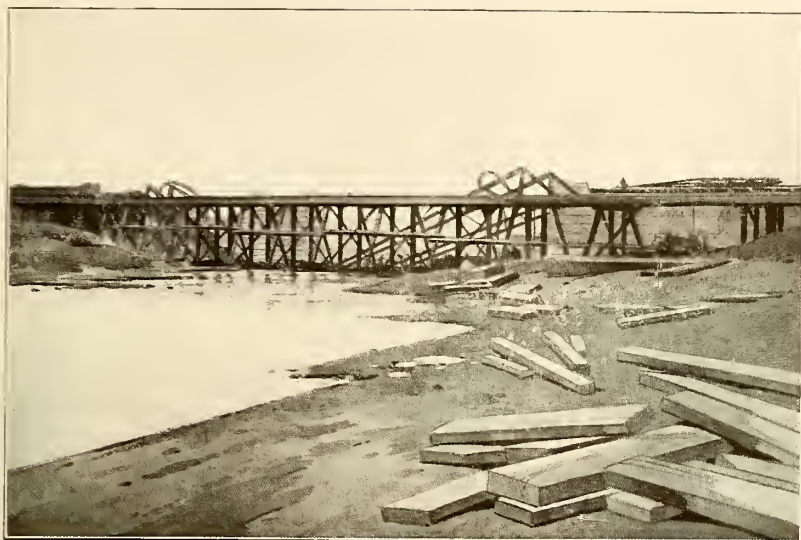
Hulp-spoorwegbrug bij Frere, gelegd naast de brug, die door de Boeren vernield was, in Januari 1900.
